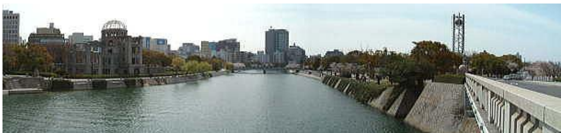
相生橋から原爆ドーム(左岸)-元安川-平和公園(右岸)を望む
